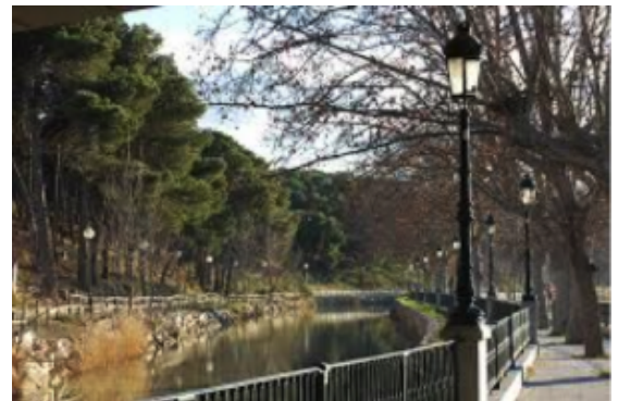
Casa de Compuertas del Bocal en el Canal Imperial de Aragón
